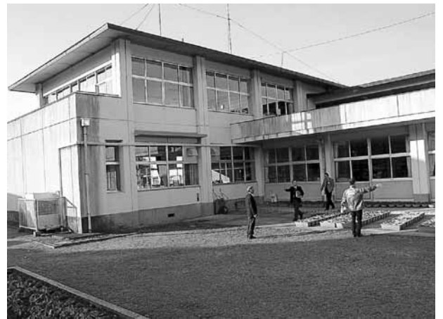
▲ 理科教室の増設など改修を行う特別教室棟
