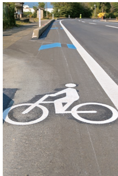
自転車は車道左側走行が原則です
