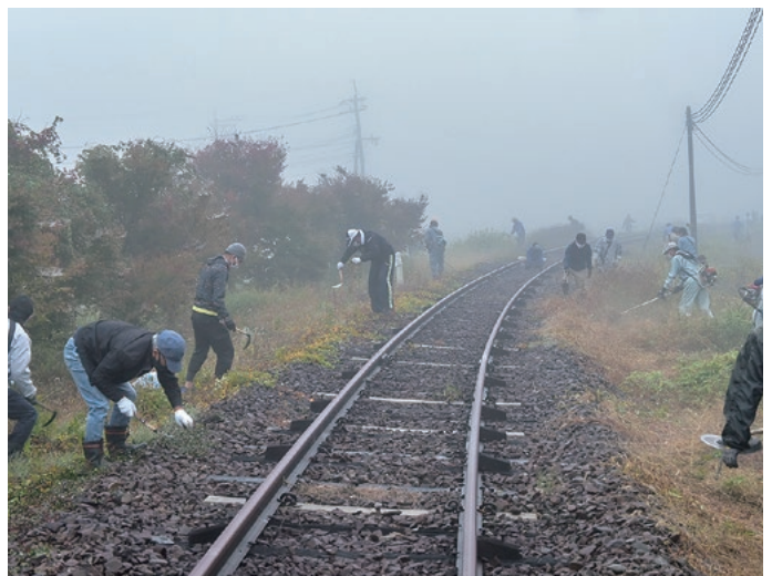
▲線路内で除草作業を行う参加者
