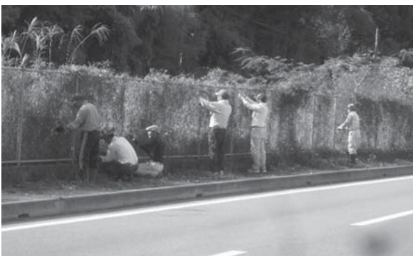
▲ フェンスに巻きついた蔓を取り除きました
