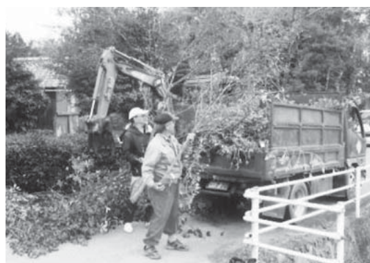
支障木枝切り
