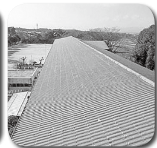
雨漏りによる 上小学校屋根改修
