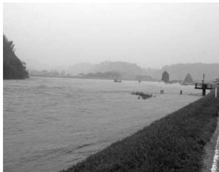
寺池地区堤防より上流方向
