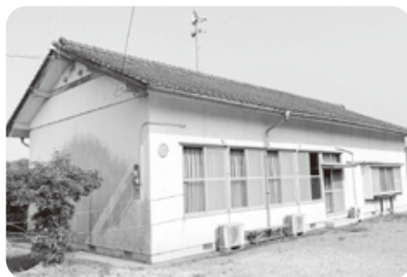
建て替え予定の清水公民分館（築51年）
