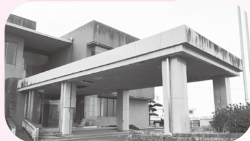
解体する旧岡原庁舎
