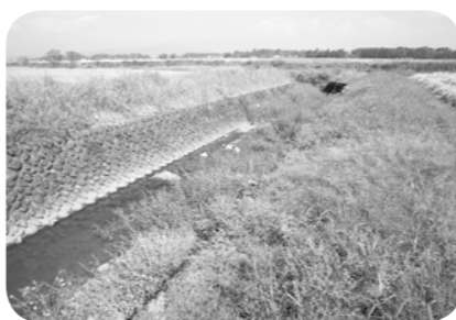
谷水川浚渫工事現場
