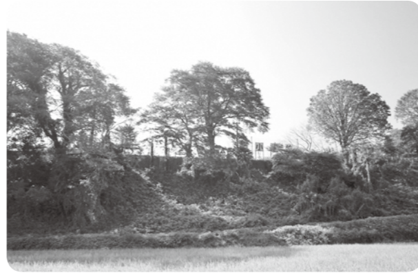
上小学校北側法面状況
