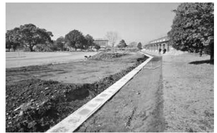
グラウンド排水対策工事の状況確認
