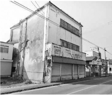
倒壊が危ぶまれる空き店舗
