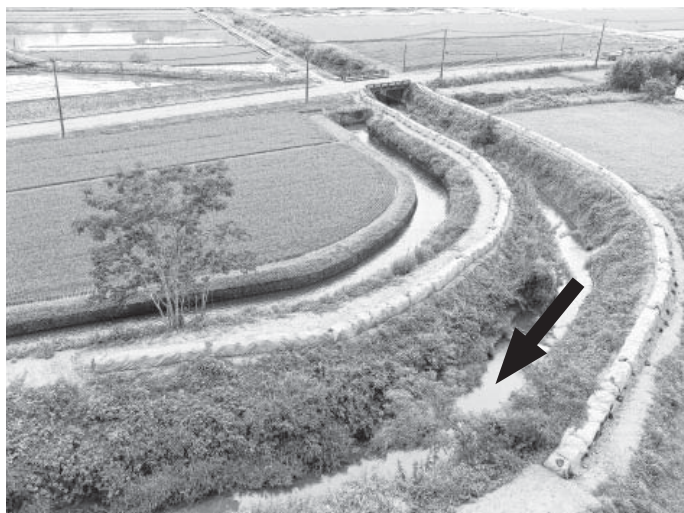
▲田頭川（現地状況）
