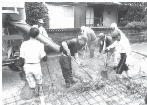
<取り組み例> ▲ 生コン舗装
