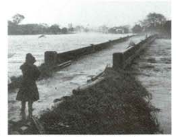
被害をうける川瀬橋
