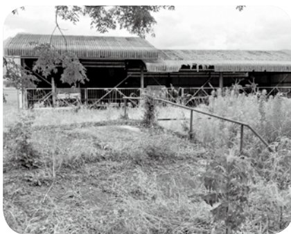
解体される岡原畜産センター
