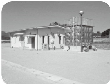
須恵送水ポンプ場の建設状況
