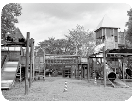
岡留公園大型遊具(使用禁止)
