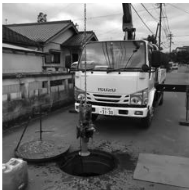
▲修理の際は通行止めを行うため、周辺の交通に影響をおよぼします
