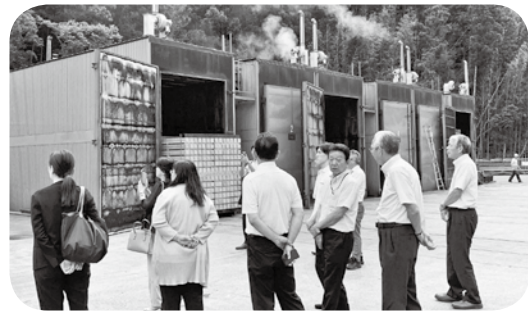
太陽光発電を利用した乾燥施設
