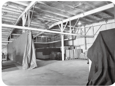
借り上げ中の(有)江里運送倉庫
