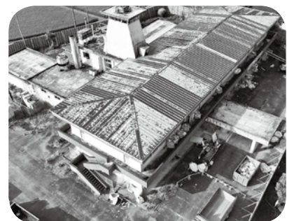
旧上庁舎解体
