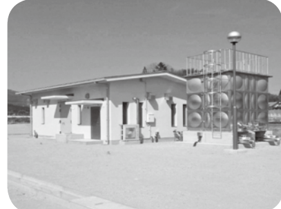
須恵送水ポンプ場の建設状況
