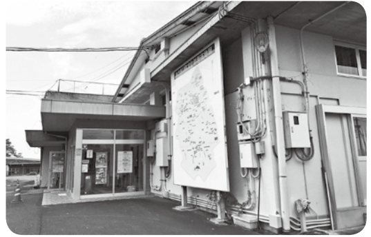
解体される予定の議場
