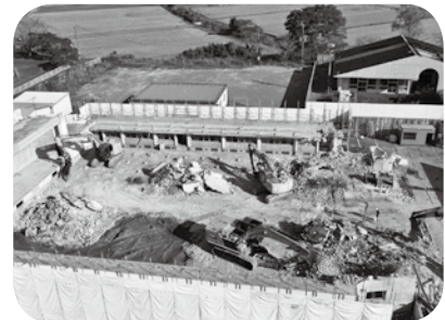
旧東庁舎解体
