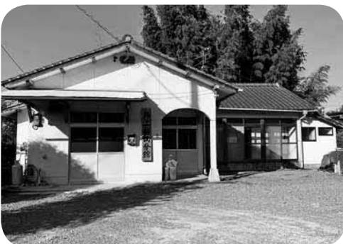
建て替え予定の井上区公民分館
