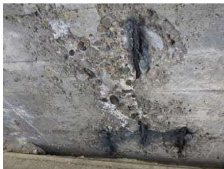
第一木上橋（上庄屋村中線）
