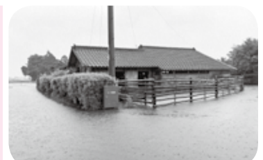
集中豪雨で床上浸水した家屋
