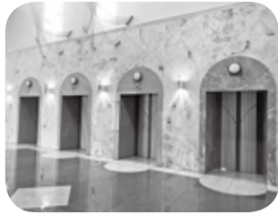
あさぎり町にある火葬場の4炉
