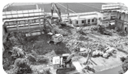
旧上庁舎解体工事
