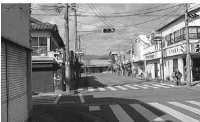
改良予定の駅前交差点
