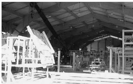
完成間近の製材工場
