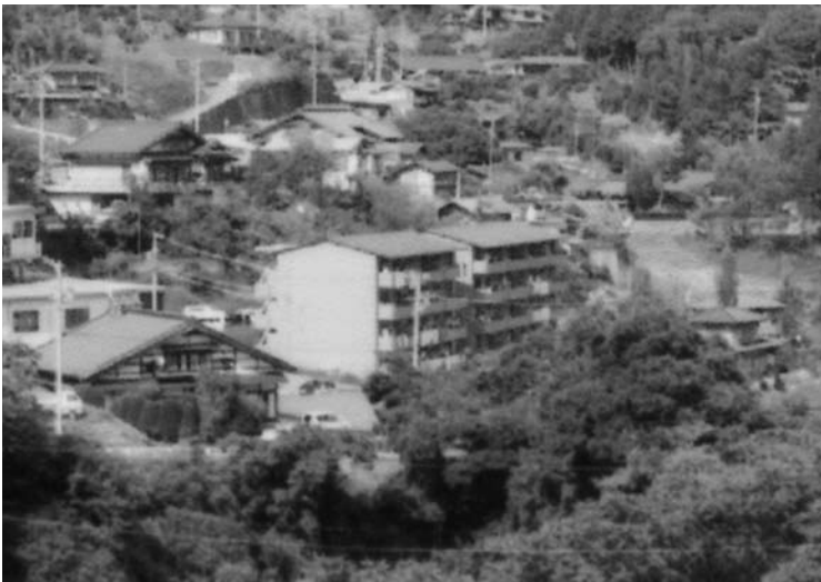
若者向け集合住宅 (中央の建物)
