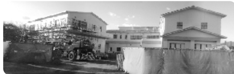
完成間近の汚泥再生処理センター
