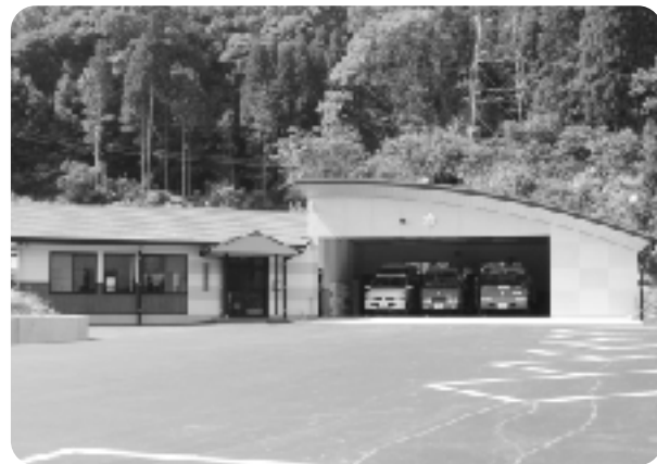
稼動した東分署 (水上村岩野)
