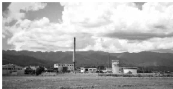
汚泥処理施設
