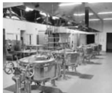
完成間近な厨房施設
