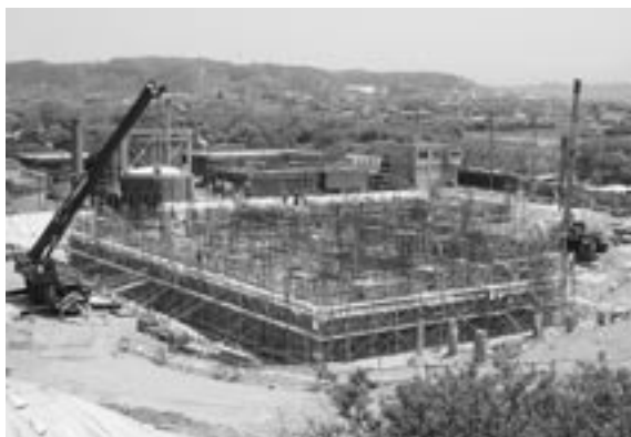
建設中の汚泥再生処理センター
