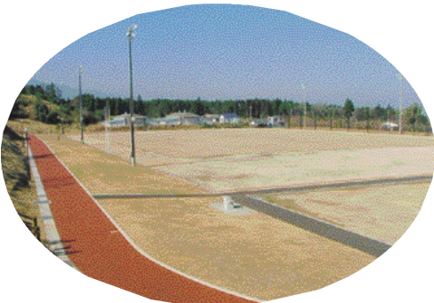
ジョギングロード及び夜間照明
