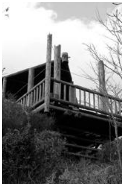
屋根が壊れたままの 高山頂上展望台
