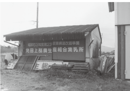
荒廃している免田畜産センターの一部(久鹿)
