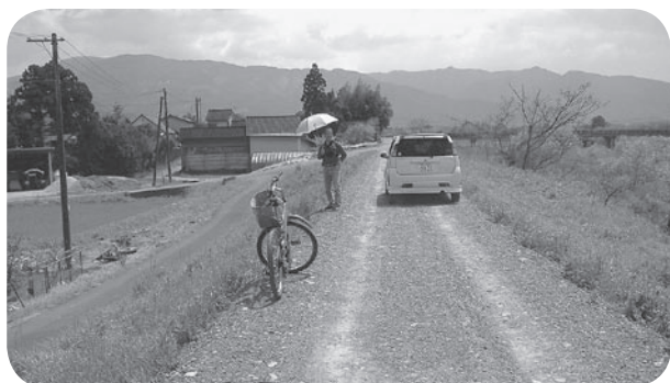
免田川右岸舗装箇所
