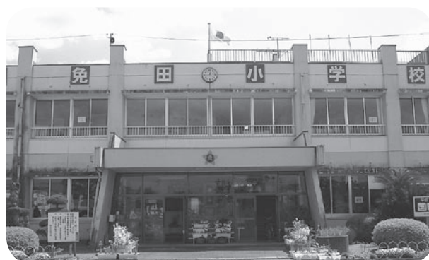
校舎の耐震診断
