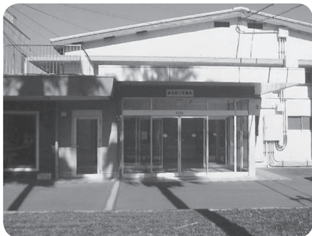
旧上中央公民館（現議会棟）
