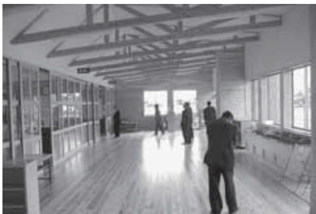
木造による教室棟 益城中央小学校低学年棟
