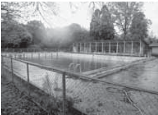
上中学校プール
