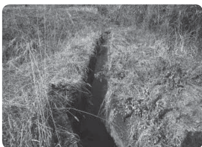
改修がまたれる用水路
