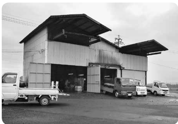
現在の作業場(免田畜産センター)
