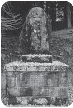
老朽化した忠霊塔
