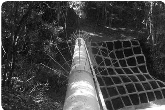
補修が完了した水管橋
