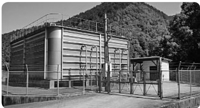
岡原第1配水池
