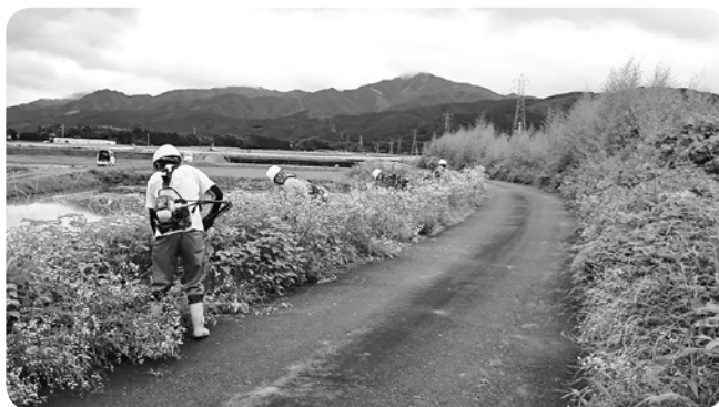
町道の除草作業
