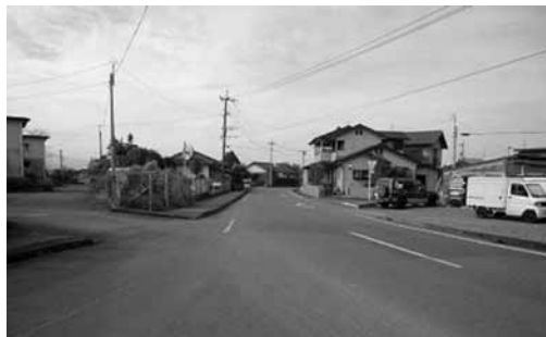
消えかかった区画線等 引きなおし
