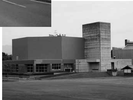
文化ホールの外壁改修
