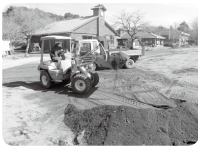
都城市御池小学校噴石除去作業
