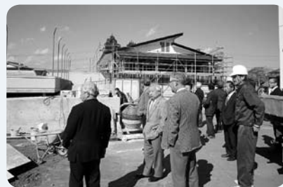
建設中のプール・管理棟の現地調査
