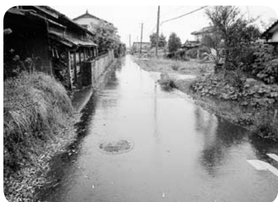
幅員のせまい集落内道路(宮籠)
