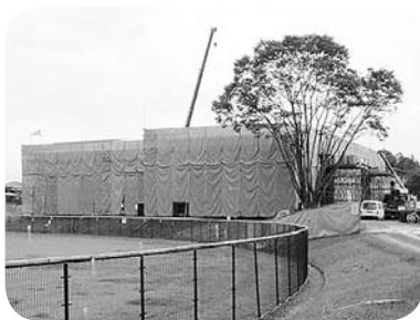
あさぎり中学校の増築校舎
