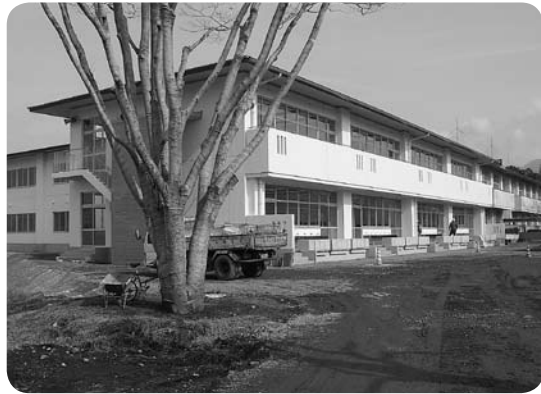
完成間近のあさぎり中学校増築棟
