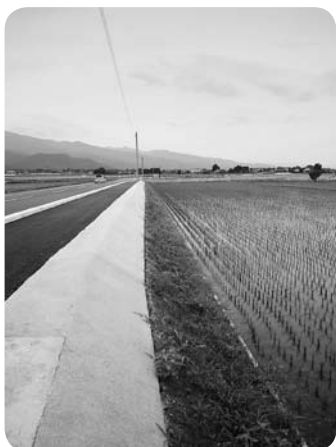
齊堂原58号線の側面施工
