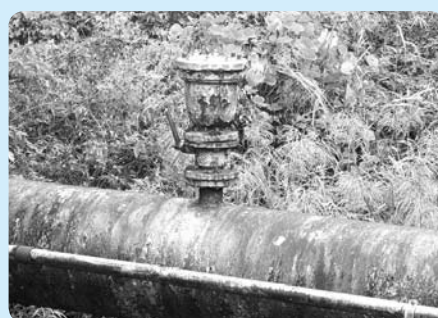
上土地改良区水管橋の塗り替え
