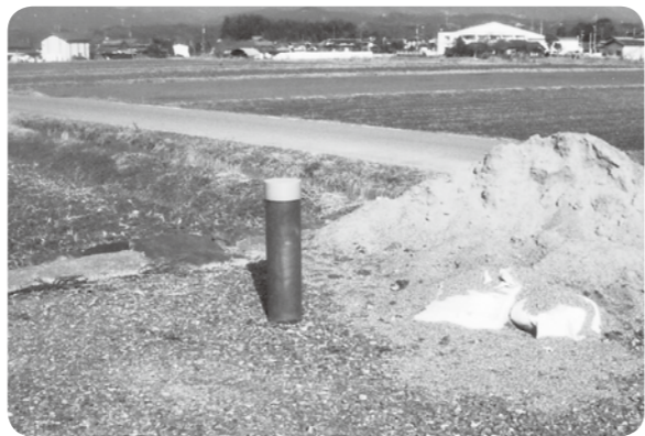
岡原試掘現場
