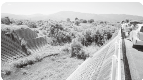
球磨川等の河川整備現地調査
