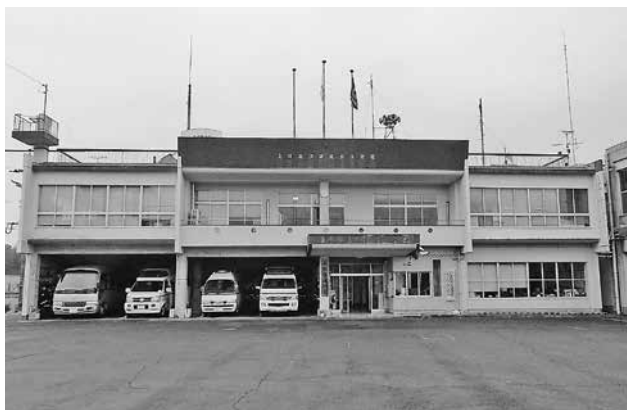
建て替えが検討されている消防本部庁舎
