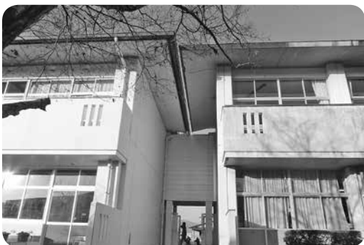
改修が急がれるあさぎり中学校
