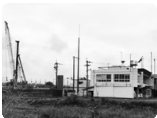
「住民の財産と安心・安全を守る」 新しい庁舎建設いよいよスタート
