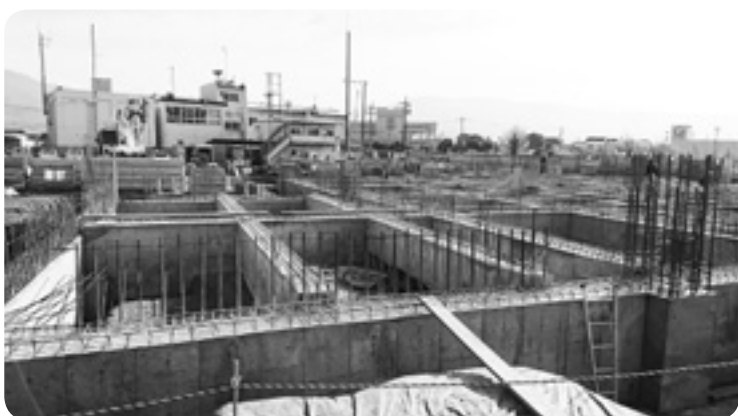
建設中の上球磨消防署庁舎
