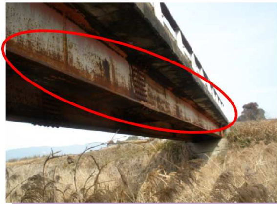
主桁の腐食
