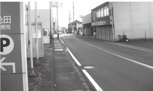
国道219号線の拡幅工事ができていない所
