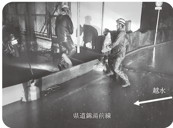
県道錦湯前線 宅地流入防止のため消防団による土嚢設置
