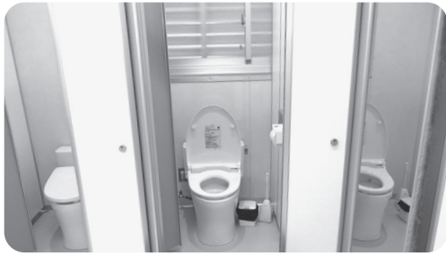
改修後のトイレ
