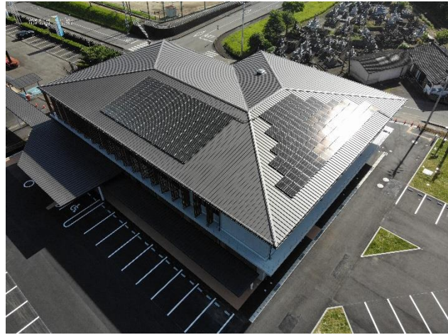
あさぎり町役場第二庁舎太陽光パネル
