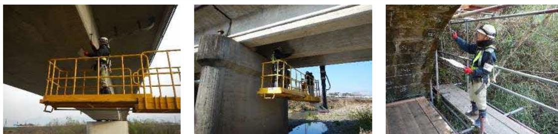
仮防錆措置等：点検時に可能な範囲で仮防錆措置を施し、橋梁の延命化を図っています。
