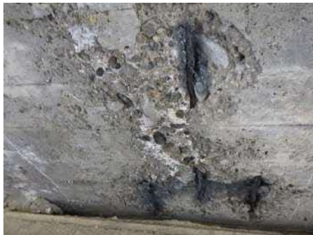
第一木上橋（上庄屋村中線）
